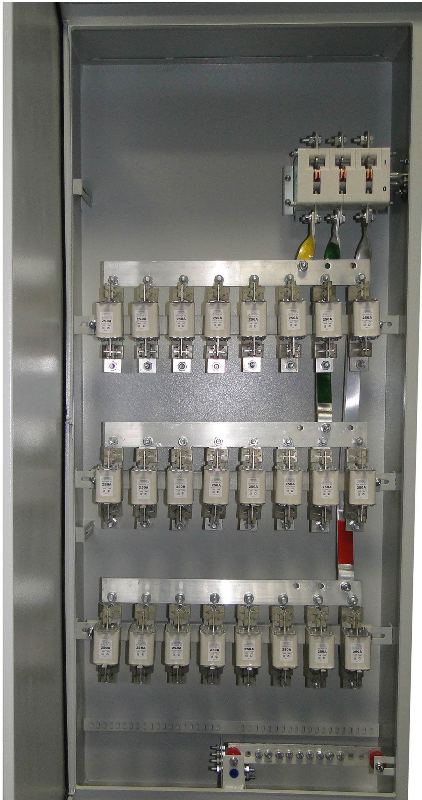
Рисунок 7 - Пример силового щита для выполнения задания
